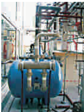
水封式阻火器，拉斯卡工程获得了在国内市场的专有权，国外设计、国内生产
