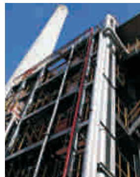
带钢结构操作平台的焚烧炉以及带蒸汽除灰系统的余热回收锅炉
