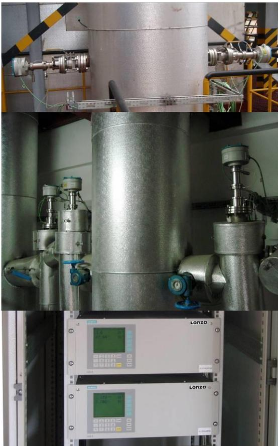
可用于  $O_2$ 、 $CO$ 、 $NO_x$ 、 $SO_2$  等气体的气体分析仪。4 个探头共用一个变送器，提供低投资、安全、高效、低维护费用和可靠的过程控制
